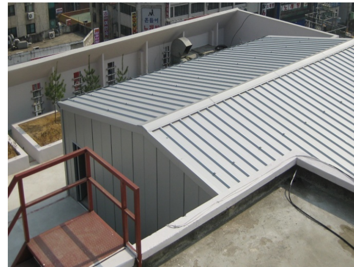
6階(屋上階)賃貸事務室の外部全景
