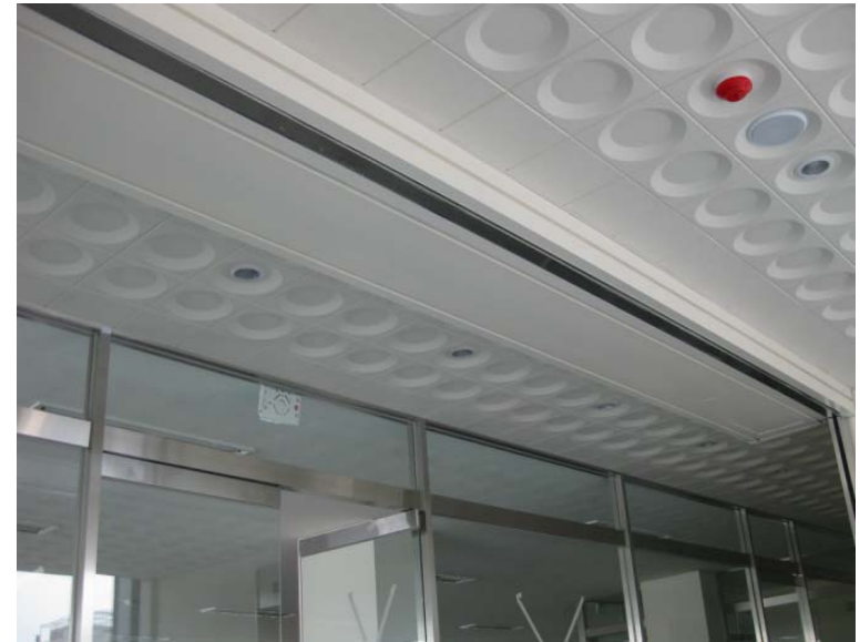
階別廊下天井外装及び防犯シャッター
