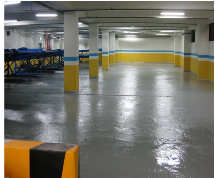
地下駐車場の全景 (23台駐車)
