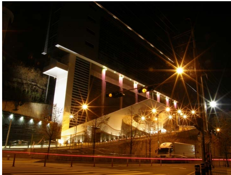
大林短期大学の全景 : ドーハビルから 200m離れている
