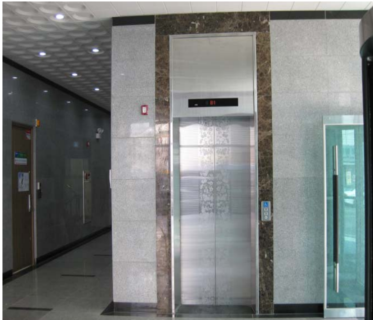
1階 ロビーエレベーター
