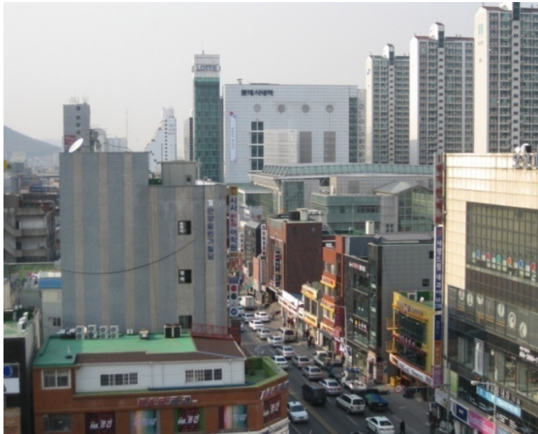
物件屋上から眺めた左側全景
