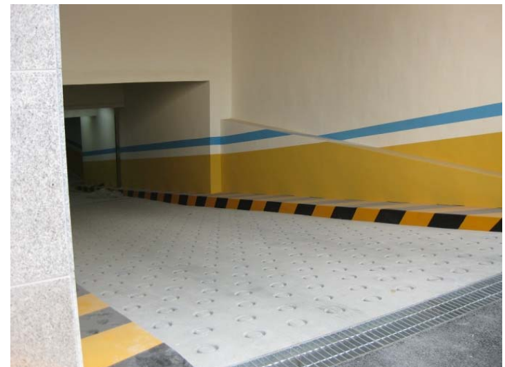
地下駐車場進入ランプ
