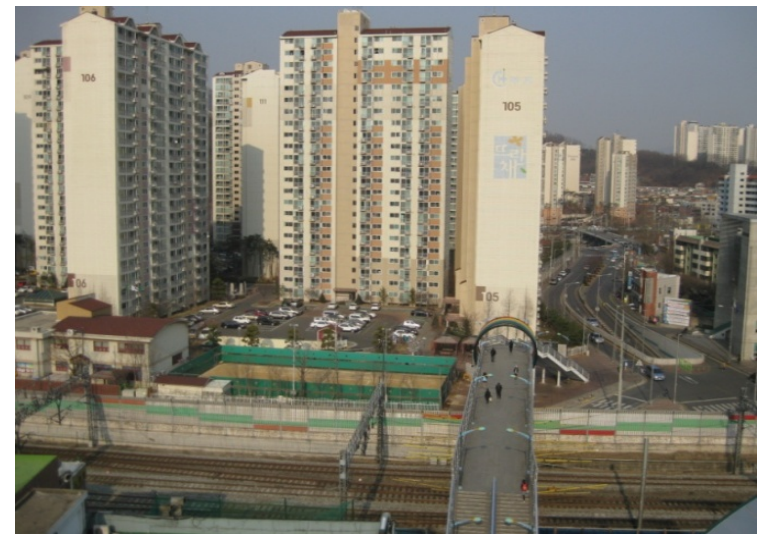
物件屋上から眺めた前面部全景
