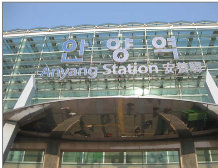
国鉄1号線の Hub駅 安養駅
