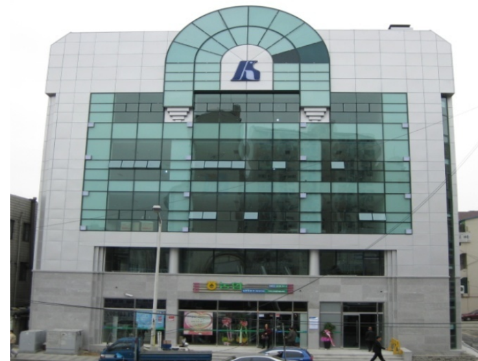
ドーハビル 正面の全景写真
